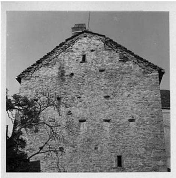
Pierres en boutisses et toit en laves – base médiathèque de l'architecture et du patrimoine (CRMH).
